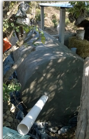
Derecha, terminando repello y fijando tubo alimentación.
